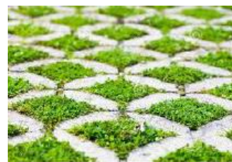
Figure 23 : Revêtement en "Greenblock végétal"
