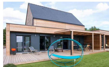
Figure 6 : Photographie d'une construction avec une toiture à double pente pour le volume en R+1 et des toitures terrasses pour les volumes en RDC. L'ensemble de la construction est habillé d'un bardage bois de teinte naturelle.
