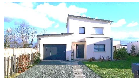
Figure 5 : Photographie d'une construction avec une toiture en monopente sur l'ensemble des volumes de la construction.
