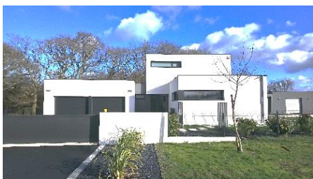
Figure 4 : Photographie d'une construction avec une toiture terrasse sur l'ensemble des volumes. Le volume à l'étage en toiture terrasse n'excède pas 50% de la surface totale de la construction.
