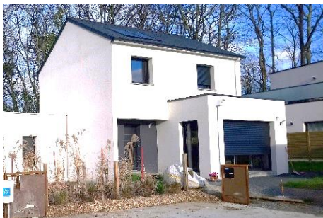
Figure 3 : Photographie d'une construction avec une toiture en double pente pour le volume principale en R+1, et une toiture terrasse pour les volumes en RDC. Murs en teinte blanc sur la majorité de la construction et teinte foncée dans le renforcement de la porte.
