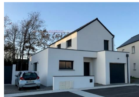
Figure 7 : Photographie d'une construction avec une toiture à double pente pour le volume en R+1 et des toitures terrasses pour les volumes en RDC
