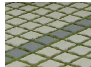
Figure 22 : Revêtement de sol en pavés engazonnés
